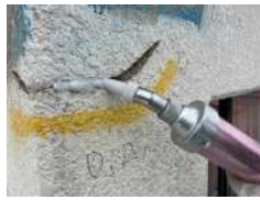
②補修状況
